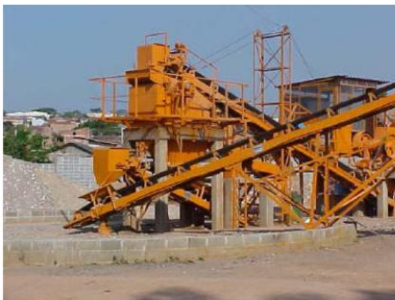
Central de Reciclagem de Entulho
